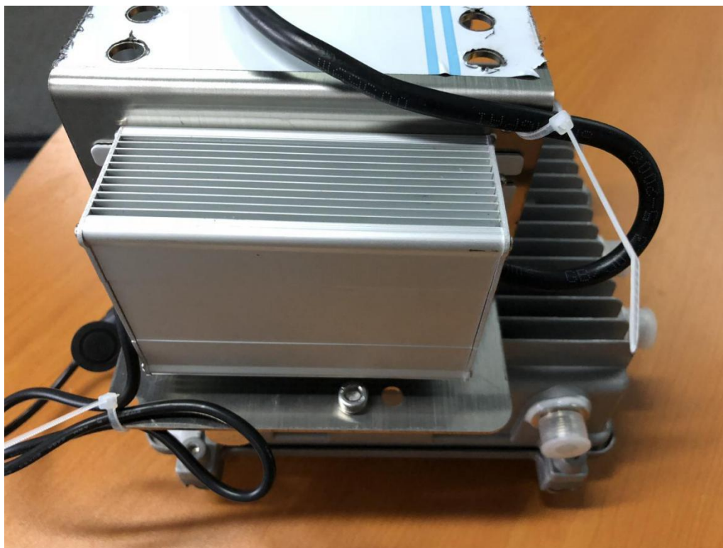
图 4-16 用扎带固定线缆
