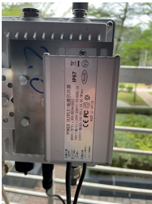
Figure 8 电源安装示意图
