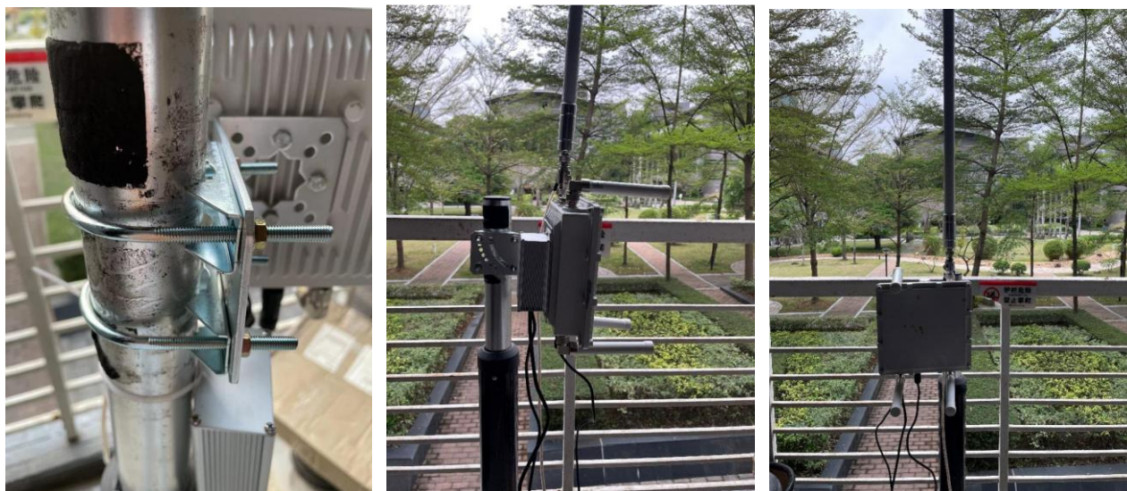
Figure 15 抱箍安装整机效果图
