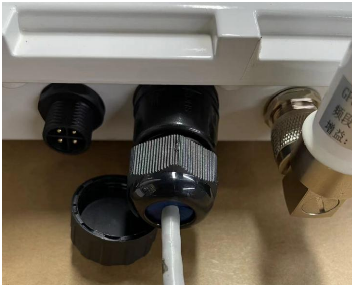
(d) Finish install the Ethernet cable
